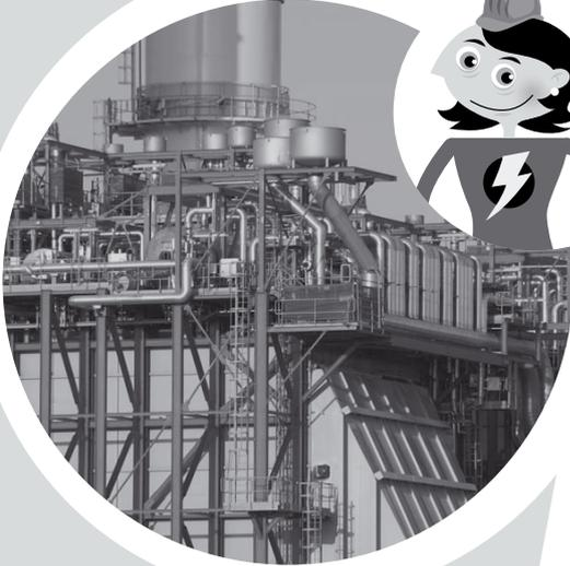
Cette électricité est générée dans une **centrale électrique**. Le générateur de cette centrale est entraîné par une turbine à gaz et une turbine à vapeur.
