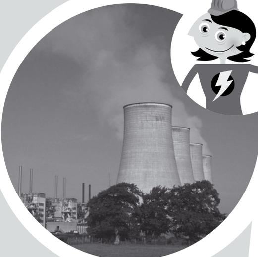
Cette électricité est générée dans une **centrale nucléaire**. La chaleur utilisée pour transformer l'eau en vapeur provient de la fission nucléaire: l'uranium, une substance radioactive, est 'fendu' et cette fission libère une très grande quantité de chaleur.
