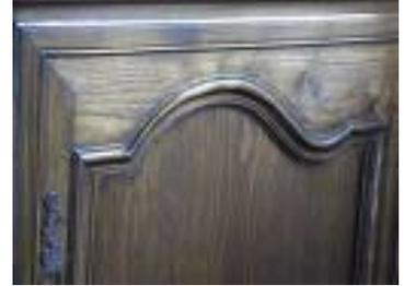
On peut constater la similitude des assemblages utilisés pour les bâtis à grand cadre et à petit cadre. Si le raccord du chant et de la moulure se fait sur la bissectrice de l'angle lorsque l'ensemble est pris dans la masse, l'assemblage se fait par tenon avec un flottage d'onglet.
